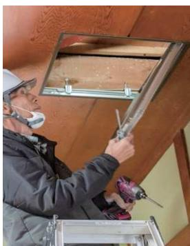
地震時に柱が、梁、土台から抜けないように補強金具で固定します。補強金具を土台に取り付ける場合、土壁の一部を取り除きます。天井裏の梁については、天井全体の解体は行わず、点検口を設置し、補強金具を取り付けます。
