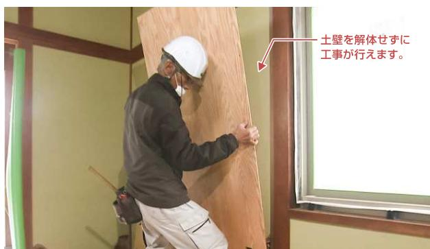
構造用合板を壁面にはめ込み、アルミアンダルにビスで固定します。この合板が従来工法の筋交いなどと同じ役割を果たし、地震の揺れに対して、抵抗します。
