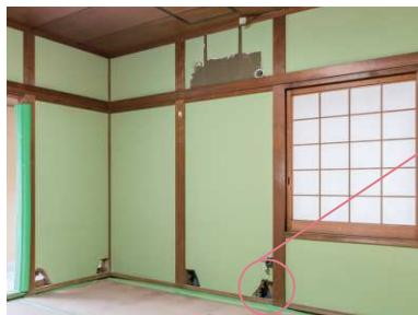
柱と梁、土台をそれぞれL型の補強金具とビスで固定します。
