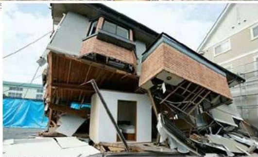
実験後の倒壊の様子
