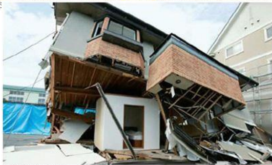
実験後の倒壊の様子
