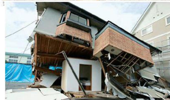
実験後の倒壊の様子
