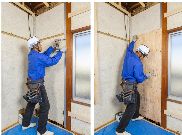
左：工事施工中の写真（アルミアングルの取付状況） 中：工事施工中の写真（構造用合板の取付状況） 右：施工前後の写真
