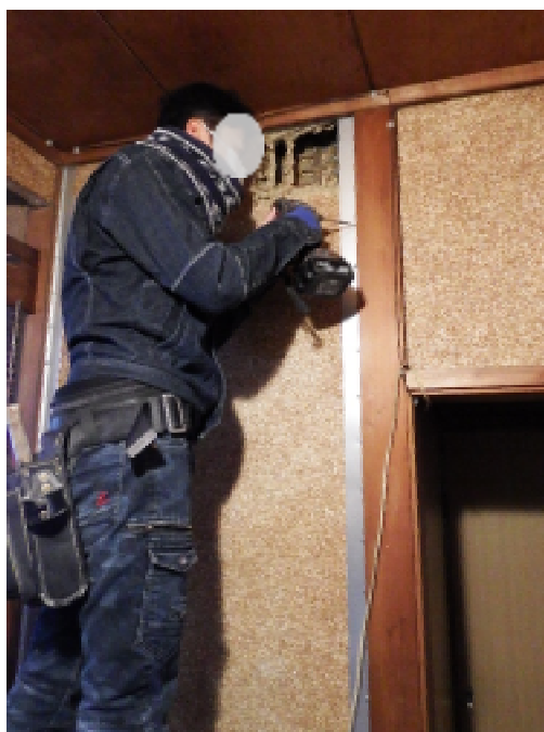
低コスト工法で施工中の補強箇所
