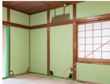
柱と梁、土台をそれぞれL型の補強金具とビスで固定します。
