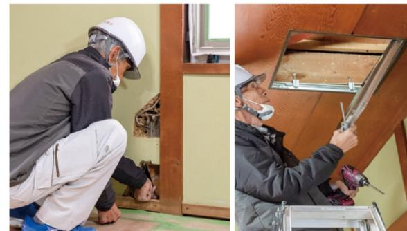
地震時に柱が、梁、土台から抜けないように補強金具で固定します。補強金具を土台に取り付ける場合、土壁の一部を取り除きます。天井裏の梁については、天井全体の解体は行わず、点検口を設置し、補強金具を取り付けます。
