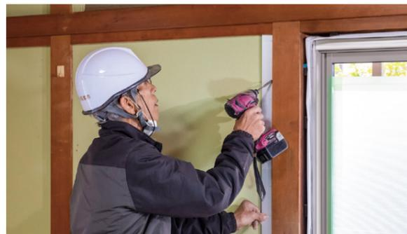
柱と壁との段差を利用して、アルミアンクルを補強箇所の柱に、ビスを用いて取り付けます。アルミアンクルは、構造用合板を柱に確実に取り付けられる役割を果たします。
