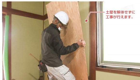
土壁を解体せずに工事が行えます。
