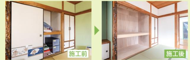
押入は、補強工事の箇所として、よく選ばれます。部屋の雰囲気や天井を崩すこともないため、施工主はもちろん、施工会社にとっても工事しやすい場所です。
